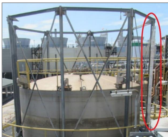
ภาพถ่ายที่ 2.2.2-45 อุปกรณ์วัดระดับแบบวัดเฉพาะ จุดแบบ Local Scale
