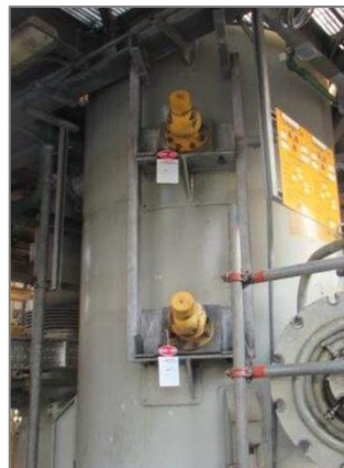
ภาพถ่ายที่ 2.2.2-7 ระบบ Interlock สำหรับหยุดการป้อนไค้ก
