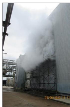
ภาพถ่ายที่ 2.2.2-62 การทดสอบผ่านน้ำยา Steam-Ammonia
