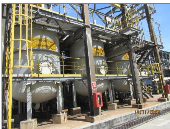
ภาพถ่ายที่ 2.2.2-8 หอเหล็กไฮดรอกไซด์ สำหรับ กำจัดซัลเฟอร์
