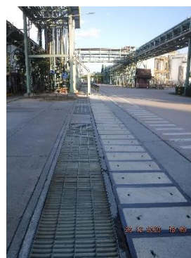
ภาพถ่ายที่ 2.2.1-12 รางระบายน้ำฝนบริเวณพื้นที่ก่อสร้าง
