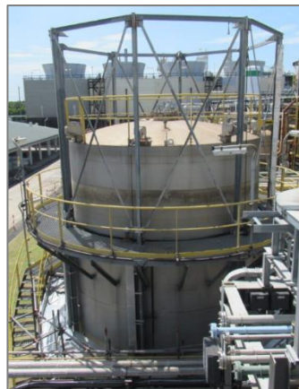
ภาพถ่ายที่ 2.2.2-44 ระบบ Gas Buffer
