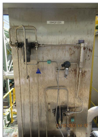
ภาพถ่ายที่ 2.2.2-13 อุปกรณ์ตรวจวัดอัตโนมัติ TOC-Online
