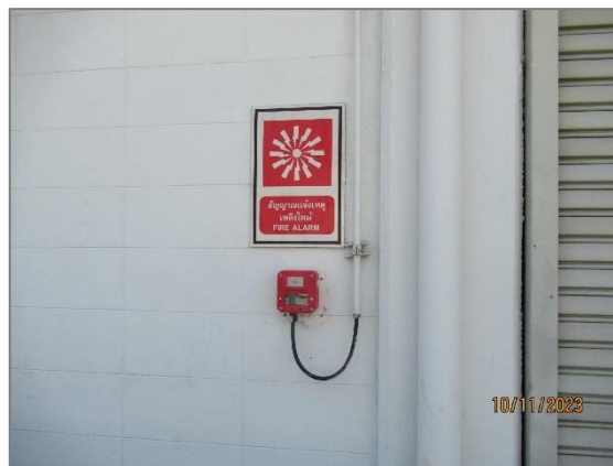
ภาพถ่ายที่ 2.2.2-59 ปุ่มแจ้งสัญญาณไฟไหม้ (Fire Alarm Button) ในส่วนผลิต CO
