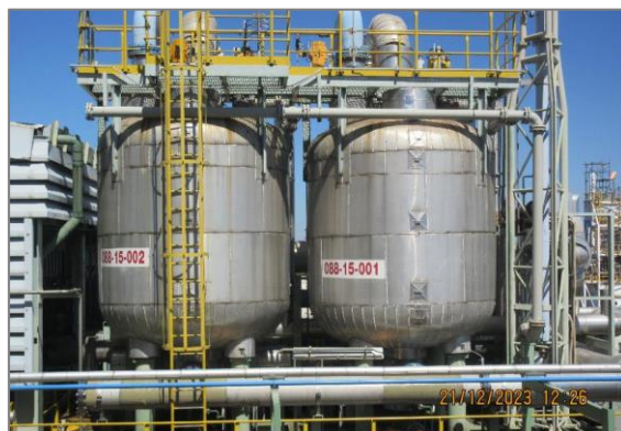
ภาพถ่ายที่ 2.2.2-2 ระบบกำจัดก๊าซเสีย (Offgas Cleaning System)
