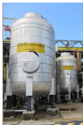
ภาพถ่ายที่ 2.2.2-9 หอด่านกัมมันต์สำหรับดูดซับซัลเฟอร์
