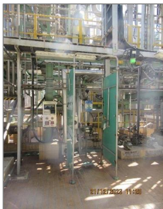
ภาพถ่ายที่ 2.2.2-39 ฝักบัวและที่ล้างตาฉุกเฉิน ในพื้นที่ที่เกี่ยวข้องกับสารเคมี
