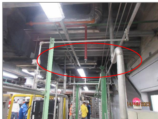
ภาพถ่ายที่ 2.2.2-55 ระบบน้ำดับเพลิงแบบ Automatic Wet Pipe Sprinkler ที่ส่วนผลิต Compounding
