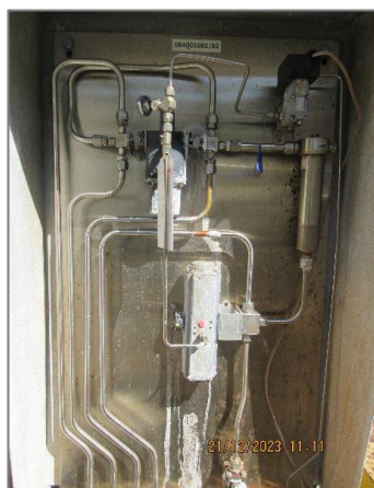
ภาพถ่ายที่ 2.2.2-12 อุปกรณ์ตรวจวัดอัตโนมัติ Phenolic Online
