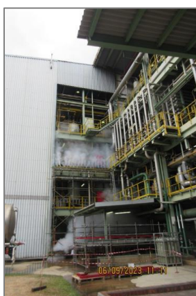
ภาพถ่ายที่ 2.2.2-62 การทดสอบผ่านน้ำยา Steam-Ammonia
