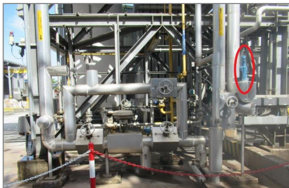
ภาพถ่ายที่ 2.2.2-43 ติดตั้งระบบ Safety Valves และฉนวนหุ้มท่อส่งไอน้ำในพื้นที่โครงการ
