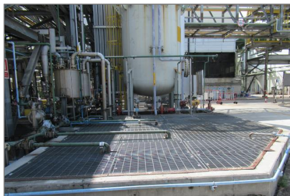
ภาพถ่ายที่ 2.2.2-18 บ่อรวบรวมน้ำเสีย (Wastewater Sump) ของส่วนผลิต CO
