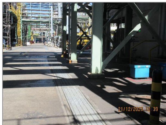
ภาพถ่ายที่ 2.2.2-15 รางระบายน้ำฝนภายในโครงการ ส่วนผลิต PC
