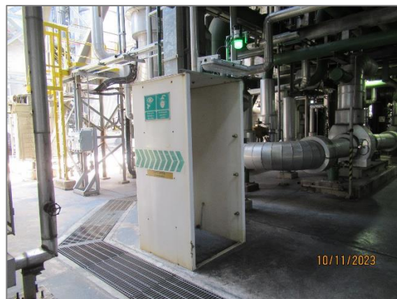
ภาพถ่ายที่ 2.2.2-39 ฝักบัวและที่ล้างตาฉุกเฉิน ในพื้นที่ที่เกี่ยวข้องกับสารเคมี
