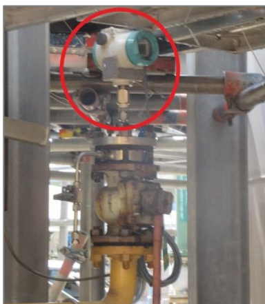
ภาพถ่ายที่ 2.2.2-47 อุปกรณ์วัดความดัน
