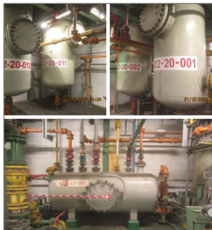
ภาพถ่ายที่ 2.2.2-1 ระบบกำจัดก๊าซฟอสจีน (Phosgene Decomposition System)
