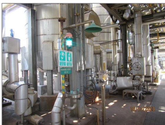
ภาพถ่ายที่ 2.2.2-41 ฝักบัวฉุกเฉิน และอ่างล้างตาฉุกเฉิน ส่วนผลิต CO
