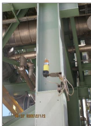
ภาพถ่ายที่ 2.2.2-52 ระบบสัญญาณเตือนแจ้งเหตุ ส่วนผลิต PC
